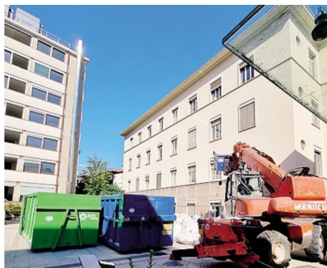
Sul cantiere sono iniziati i lavori preliminari alle demolizioni
