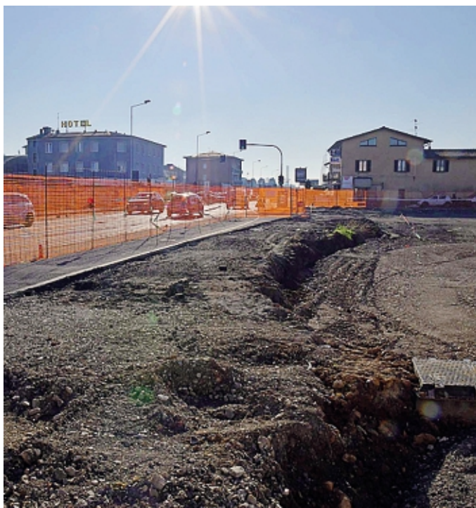
Il cantiere della nuova rotonda a Dalmine CESNI
