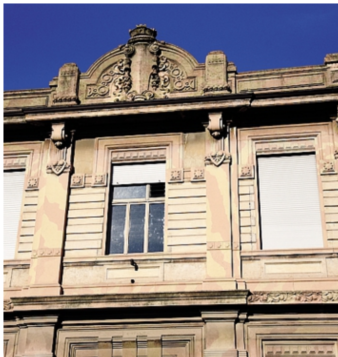
La facciata della palazzina che ospiterà la nuova sede Isrec FOTO BEDOLIS
